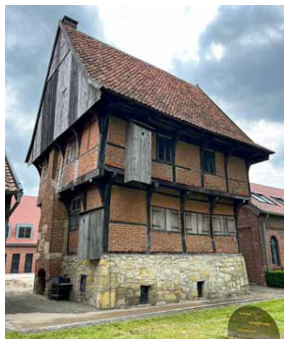
Die Rückseite des restaurierten Fachwerkspeichers mit den beiden Abtrittkern
