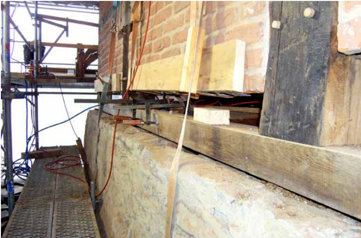
Die Restaurierung der Konstruktionshölzer des Speichers erfolgte unter Verwendung von historischem Eichenholz aus Wiederverwendung und abgelagertem neuen Eichenholz. Konstruktive Detaillösungen zur statischen Stabilisierung an Detailpunkten wurden mithilfe von historischen Zimmermannstechniken vorgenommen
