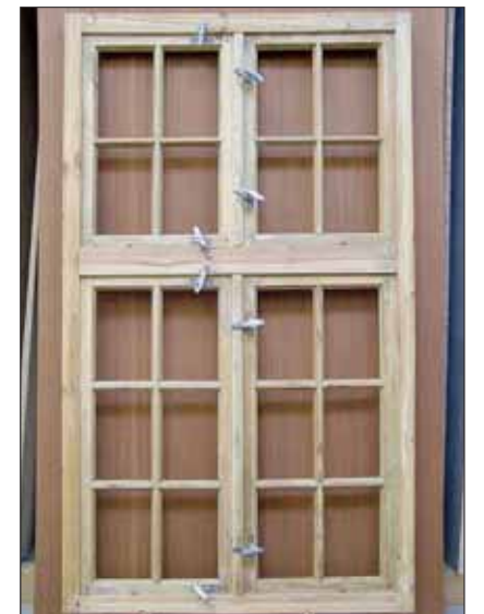
Die unterteilten Fenster mit Sprossen und kunstvollen Beschlägen wurden demontiert und in der Werkstatt – je nach Zustand – restauriert oder rekonstruiert.
