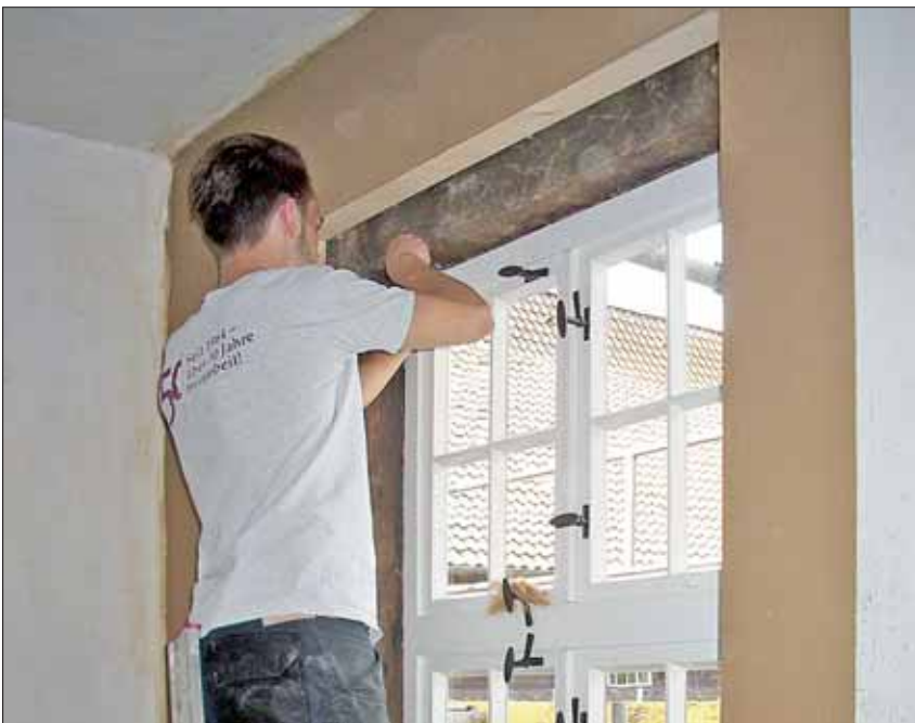
126 der 281 Fenster konnten gerettet werden, die übrigen wurden exakt nach den historischen Vorbildern neu aus Kiefernholz rekonstruiert.
