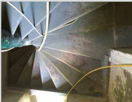
Bei früheren Sanierungsarbeiten wurden in die Stufen der Treppe im Burgvogt neue Holzstücke eingesetzt. Im Zuge der jetzigen Überarbeitung wurden diese Ausbesserungsspuren beibehalten.
