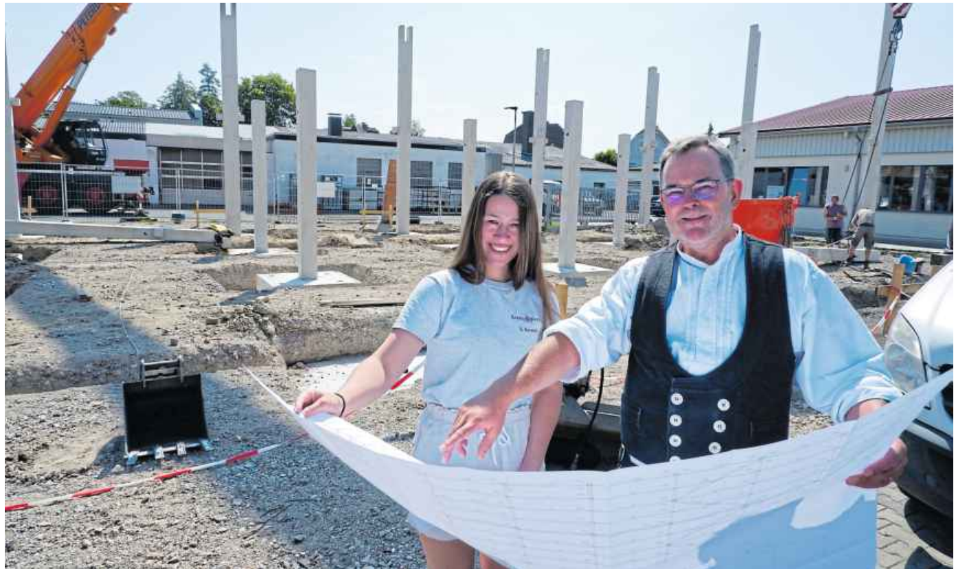
Stefanie und Guido Kramp, Geschäftsführer des Unternehmens, schauen sich die Pläne für die Firmenerweiterung an. Im Hintergrund laufen die Arbeiten.
