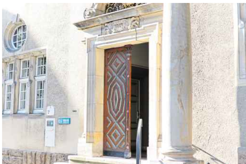
Auch das Portal des Amtsgerichts aus den Jahren 1912/13 soll restauriert werden. Die gesamten Arbeiten ziehen sich über drei Jahre.
