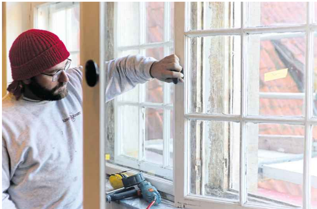
Tischler Pablo Nadig kennt sich mit historischen Elementen aus – hier die Fenster im Saal des Amtsgerichts. Sein Arbeitsplatz befindet sich oft in denkmalgeschützten Gebäuden, etwa Schlösser oder Rathäuser. MT-Fotos: Alex Lehn
