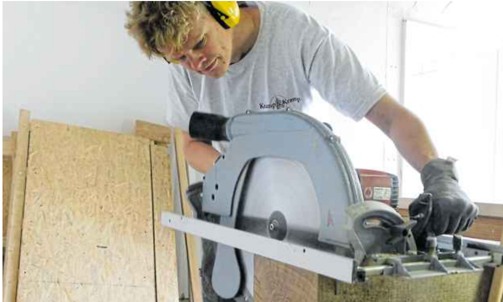
Simon Pötsch hat sich für eine Ausbildung bei Kramp und Kramp entschieden, weil ihn die Arbeit an historischen Gebäuden, auf die das Unternehmen spezialisiert ist, interessiert.
