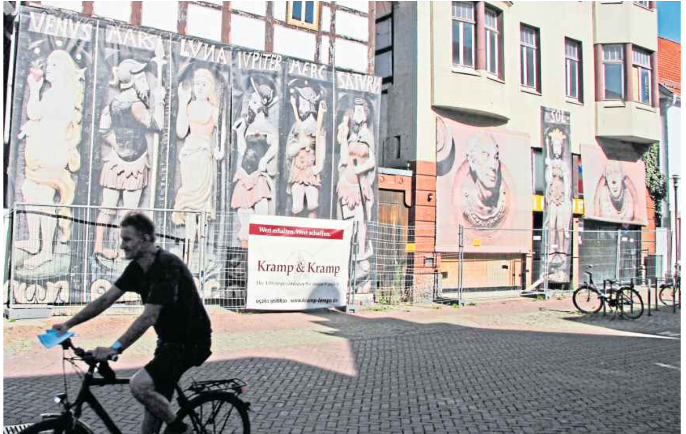
Kein schöner Anblick trotz der bunten Planen. Das aber könnte sich bald ändern. Die Firma Kramp wird die beiden Häuser des ehemaligen Hanse-Centers restaurieren.
