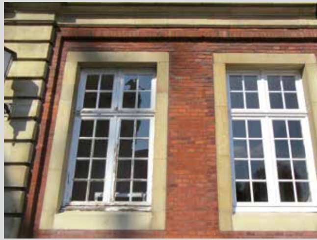
Das Fenster links wartet noch auf die Restaurierung, das Fenster rechts wurde von Kramp & Kramp bereits aufgearbeitet.
