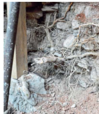
In das Innere der Mauer sind viele dicke Wurzeln hineingewachsen. FOTO: MICHAELA WEISSE
