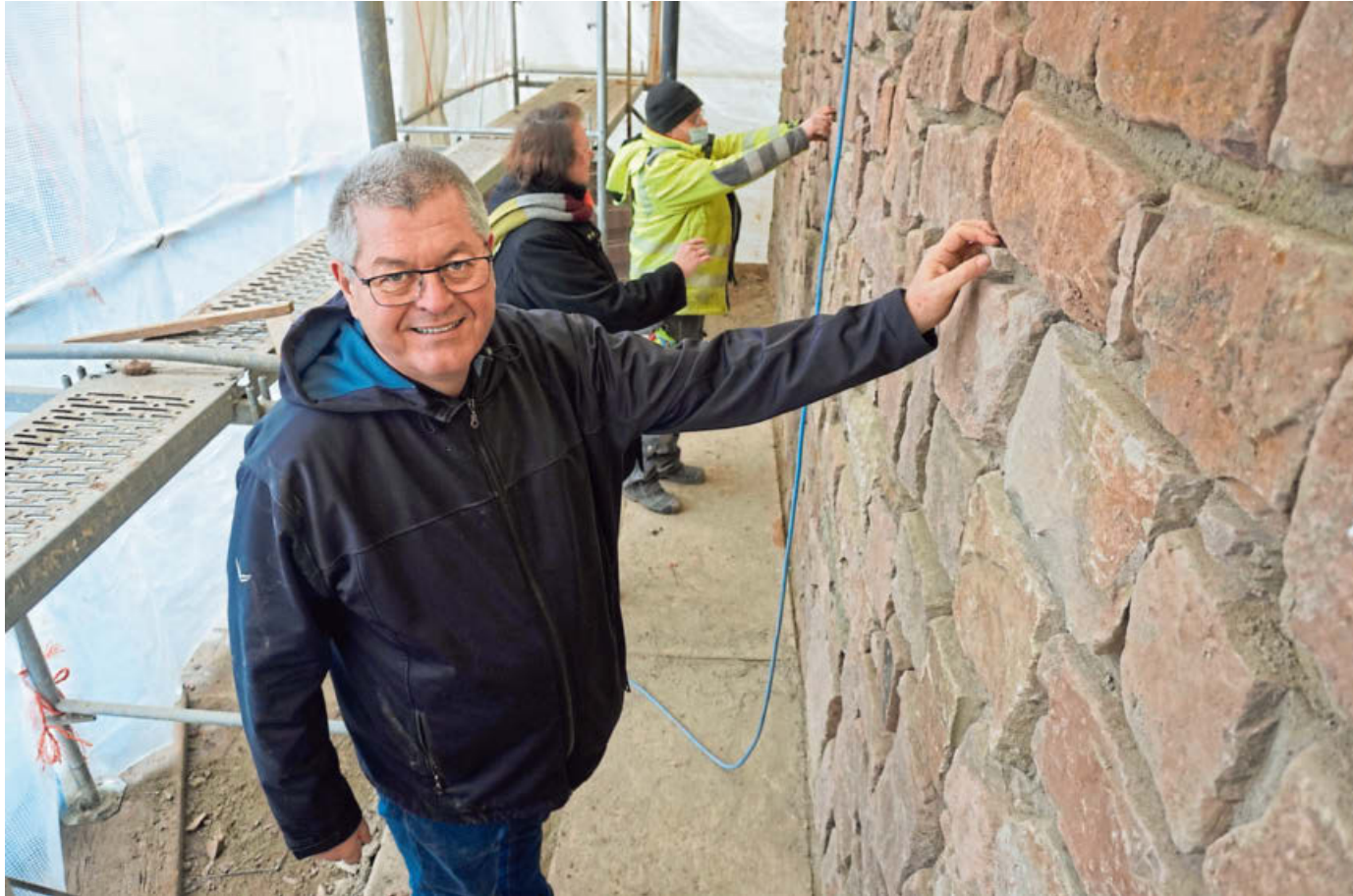
Architekt Andreas Kropp zeigt einen bereits sanierten Teil der Stadtmauer. Zwischen den neuen Sandsteinen sind auch alte Steine eingefügt worden. Farbllich ist kaum ein Unterschied zu erkennen.
