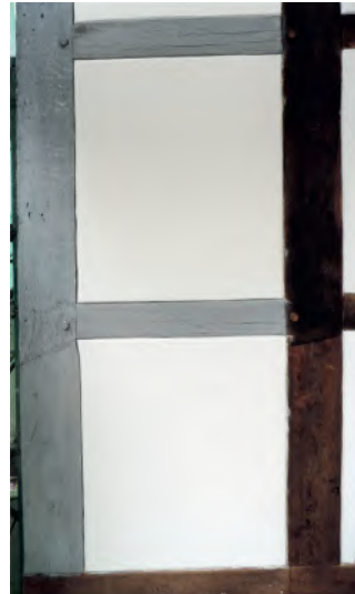
Fachwerk grundiert (rechts) und erster Anstrich (links)
