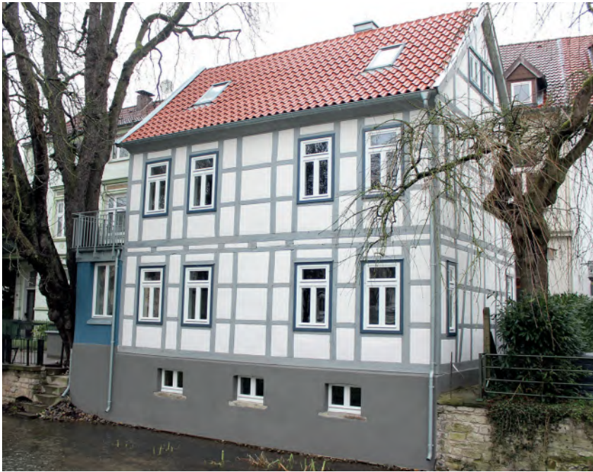
Fachwerk nach vollendetem Anstrich
