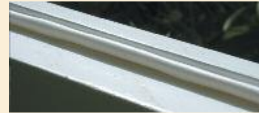
Zusätzliche Silikon-Zugluftdichtung in den Blendrahmen eingefräst und eingezogen.
