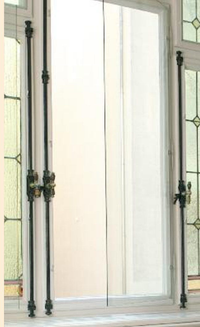
Ansicht einer komplett montierten Vorsatzscheibe (geöffnet).
