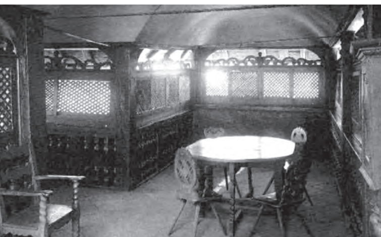
Das Belvederchen in einer historischen Aufnahme und beim Wiederaufbau.
