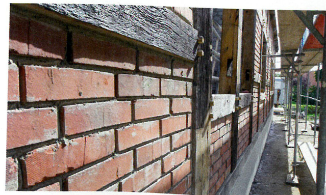
Wand eines historischen Fachwerkbbaus während und am Ende der Sanierung
