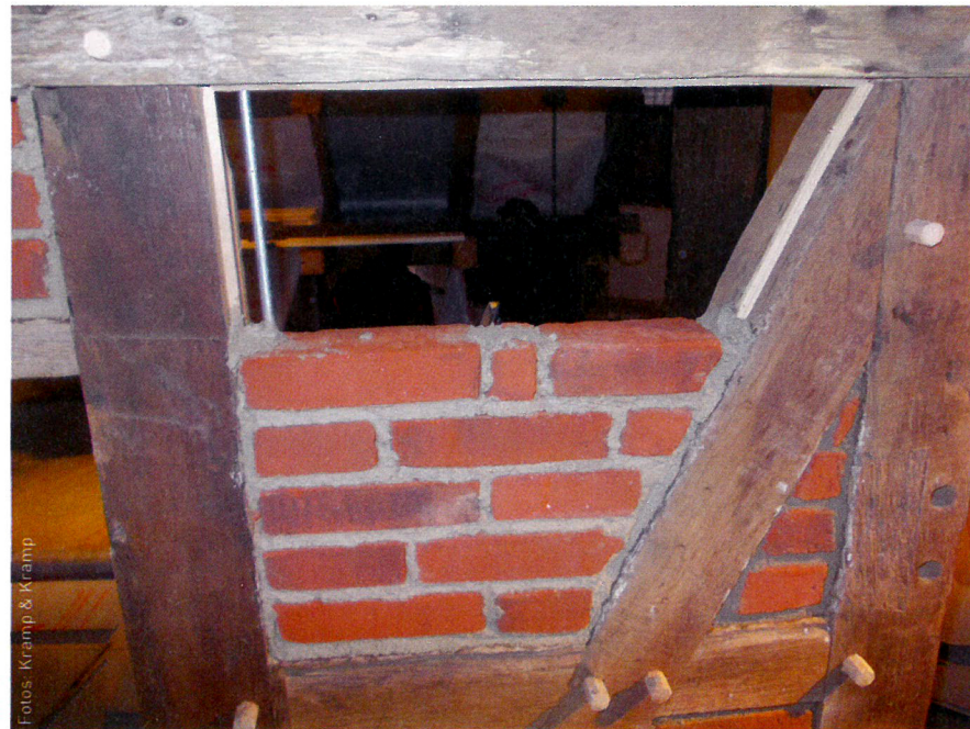
Neben Lehm sind weiche Backsteine eine Option für die Erneuerung von Gefachen.
