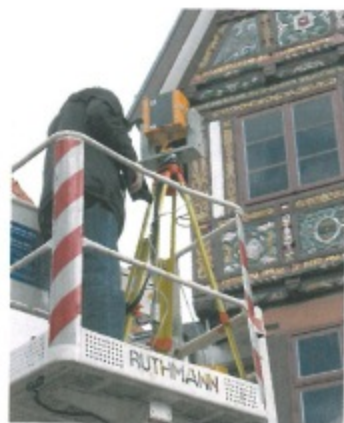
Eine akribische Dokumentation für die Rekonstruktion der Details ist unerlässlich.
