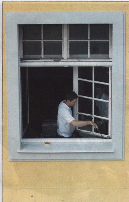
Tischler Dieter Nagel baut in diesem Jahr etwa 100 alte Fenster am Rathausgebäude aus. In der Lemgoer Werkstatt werden sie abgebeizt, neu lackiert und vor allem mit Isolierglas versehen. Fotos: Moritz Winde
