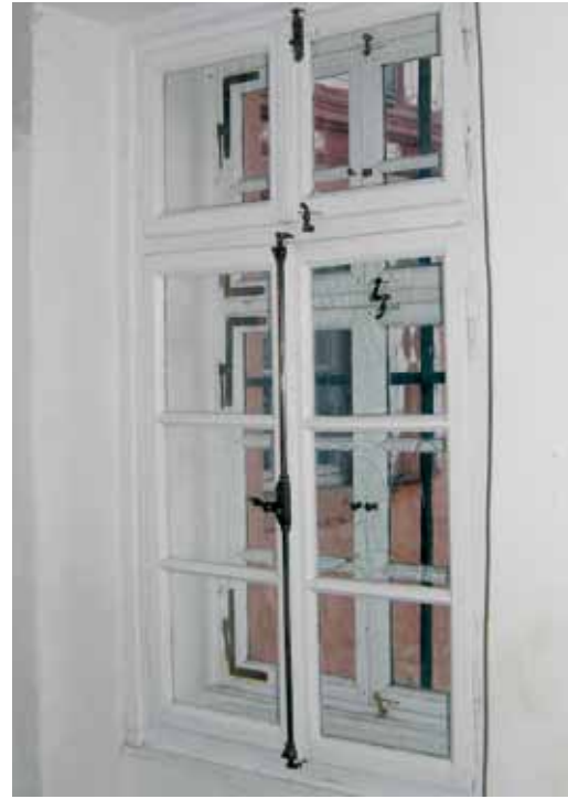
Bei dieser Lösung mit einem Innenvorfenster wurden historische Beschläge wiederverwendet.
