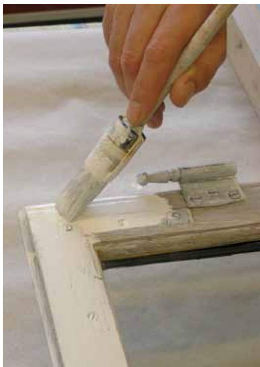
Dieses historische Fenster erhält bei der Aufbereitung eine Oberflächenbeschichtung mit Leinölfarbe.
