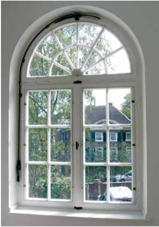
Für den Laien kaum sichtbar wurde dieses restaurierte Fenster mit einer Energiesparvorsatzscheibe ergänzt.
