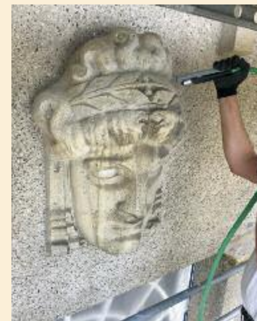
Substanzschonende Reinigung im Microstrahlverfahren.
