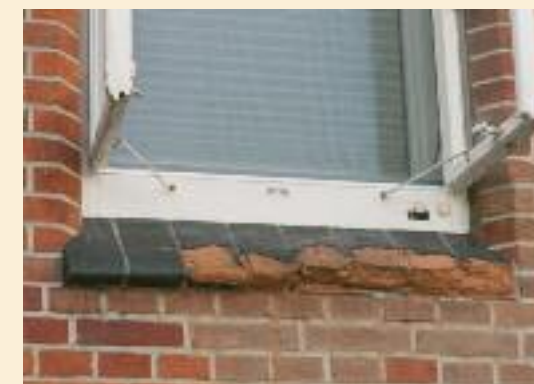
Historische, glasierte Ziegelsteine, teilweise restauriert, instandgesetzt und durch neue, brandglasierte Ziegel ersetzt.
