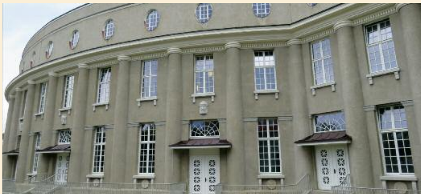
Hannover, Hannover Congress Centrum (HCC) Historische, denkmalgeschützte Stuck- und Putzfassade nach der Instandsetzung.
