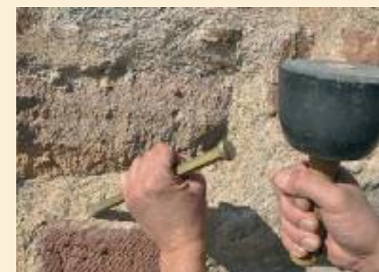
Handwerkliche Steinmetzbearbeitung am Fugenwerk und Scharrierungen der Sandsteinoberflächen.
