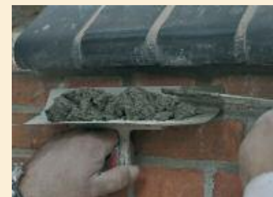
Ergänzungen und teilweise Erneuerungen der historischen Verfugung an der Ziegelfassade.
