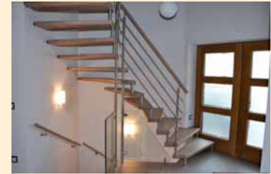
Treppenanlage neu geplant und eingebaut Holz-/Stahlkonstruktion
