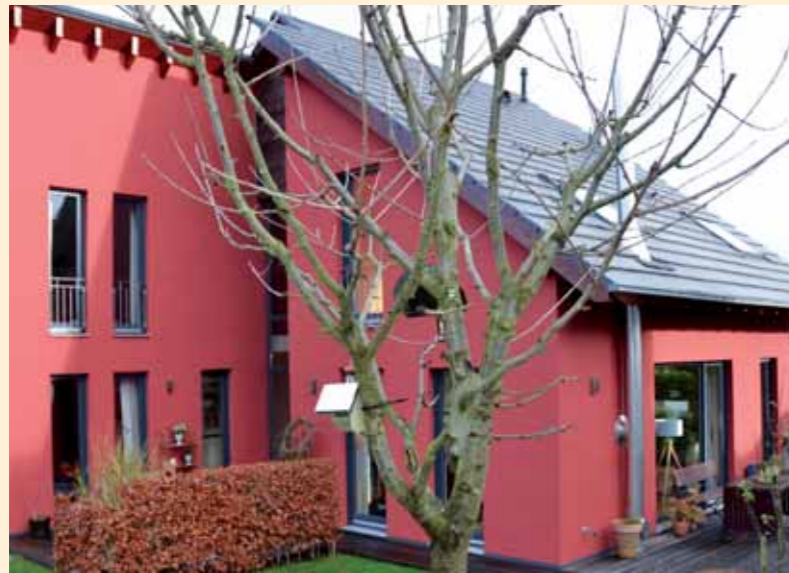
Sanierungsobjekt Lage, Einfamilienhaus, Baujahr 2004 Oben: Bestandsaufnahme, Feuchtigkeitsschäden an der Fassade Mitte: Sanierungsarbeiten, Neuputz und Fassadenanstrich Unten: Saniertes und modernisiertes Objekt
