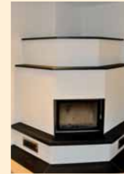
Kamin neu geplant und eingebaut mit Schieferabdeckungen
