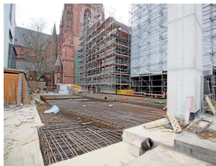
Am Dom entsteht das Fundament des Nachbaus.
