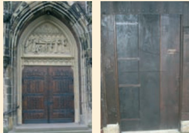
Kirchen-Portal nach der Restaurierung.
