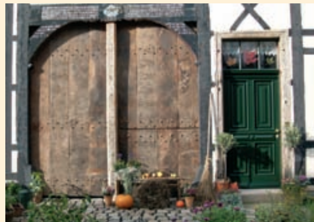
Rekonstruktion eines Deelentores nach historischen Vorlagen, mit handgesägten Eichenbohlen.
