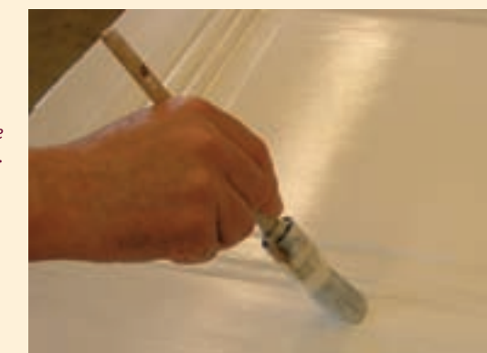
Handgestrichene Leinöl-Oberflächen.
