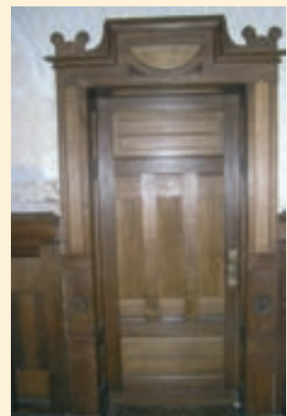
Original Oberflächenfassung mit Schellackmattierung aufgefrischt.
