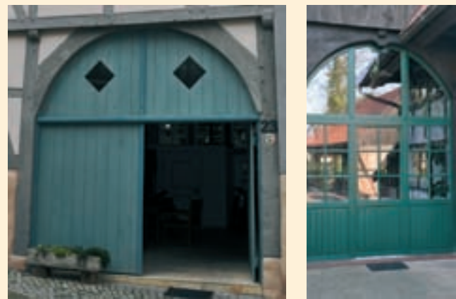
Neu angefertigtes Deelentor nach historischer Vorlage.
