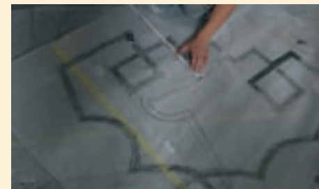
Ausarbeiten von Schablonen für die fehlenden Stuckelemente nach Befund.
