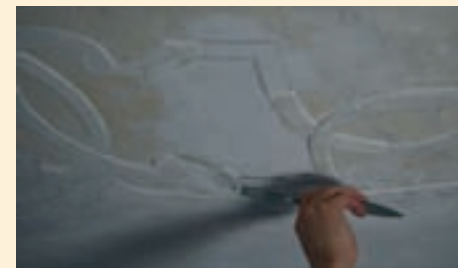
Anarbeiten fehlender Stuckelemente.
