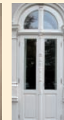
Rekonstruktion einer isolierverglasten Balkontür.
