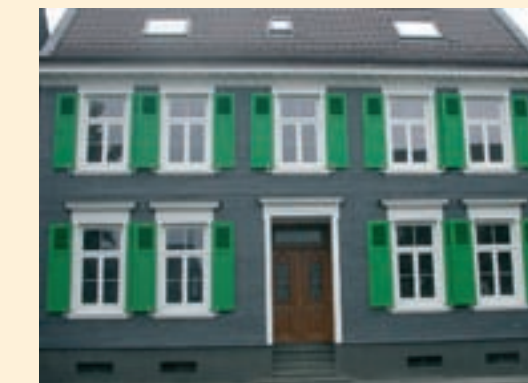
Wermelskirchen, Baudenkmal. Fensterrekonstruktion mit 10-mm-Isolierglasscheiben mit Walzglas.
