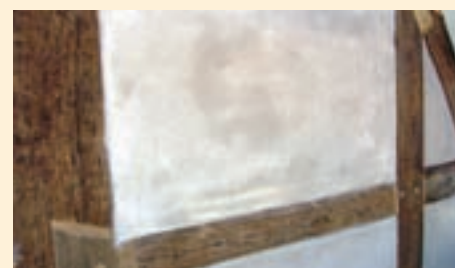
Zweilagiger Kalkputz als Außenputz, Oberfläche abgerieben, mit umlaufenden Kellenschnitt.
