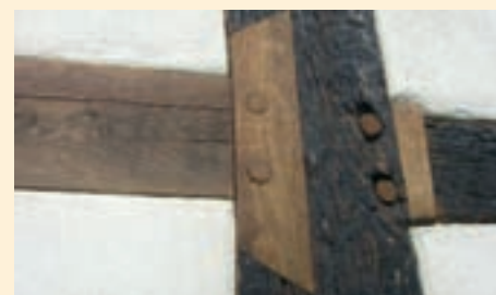
Fachgerecht ausgeführte Fachwerkreparatur.
