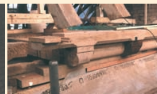
Dachstuhlsanierung im Kloster Marienmünster.
