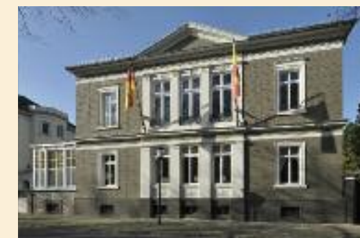
Detmold, Villa Verein Ressource. Komplette Fassadensanierung.
