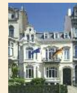
Brüssel, Vertretung des Landes Rheinland-Pfalz. Fenstersanierung und Montage von Energiespar- Vorsatzscheiben.
