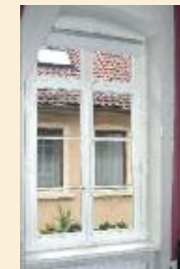
Rekonstruktion eines Innenvorfenster als Kastenfenster.
