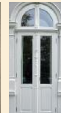
Rekonstruktion einer isolierverglasten Balkontür.
