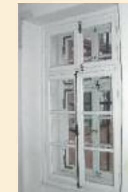
Rekonstruktion eines Innenvorfenster als Kastenfenster.
