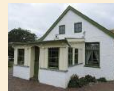
Langeoog, Heimatmuseum Seemannshus. Restaurierung und Rekonstruktion historischer Fenster.
