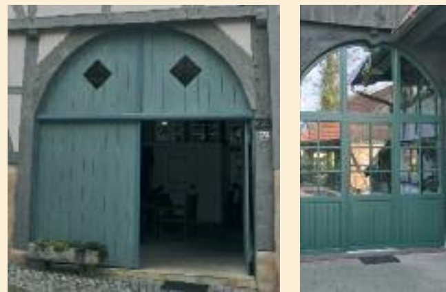
Neu angefertigtes Deelentor nach historischer Vorlage.
