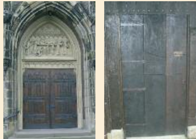
Kirchen-Portal nach der Restaurierung.
