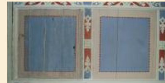
Rekonstruktion Deckenfassung, Burkersdorf Oben: Konservierung der historischen Farbfassung mit Japanpapier und Klucel. Unten: links originale Fassung, rechts Rekonstruktion der Farbfassung.
