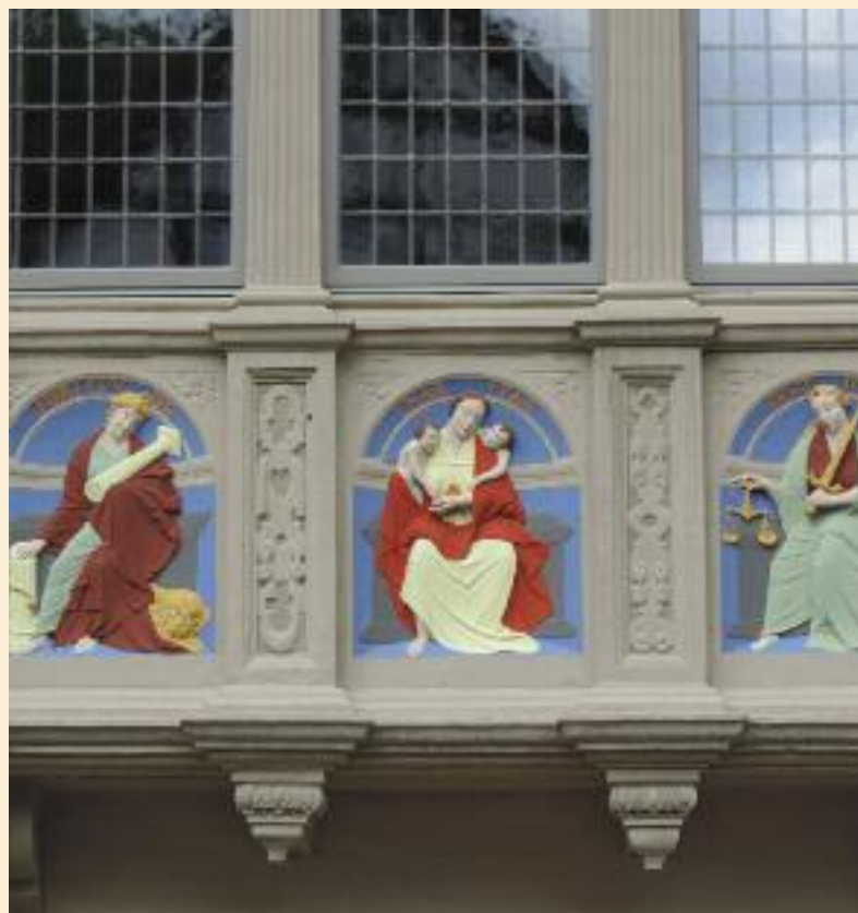
Hexenbürgermeisterhaus in Lemgo, Fassadenrestaurierung (Naturstein, Putz, Farbfassung und Fenster).
