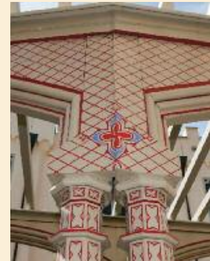
Montierter Kapitellkopf an der Hauptanlage.
