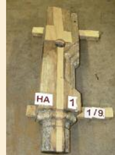
Kapitellkopf nach dem Entlacken und der Holzrestaurierung.
