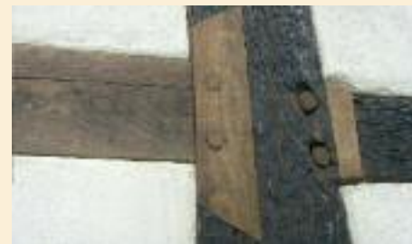
Fachgerecht ausgeführte Fachwerkreparatur.
