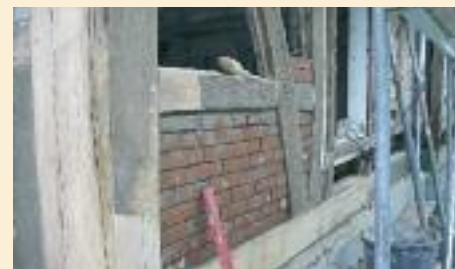
Neue Gefachmauerung mit weichgebrannten Westfalen-Backsteinen, mit Trasskalkmörtel vermauert.
