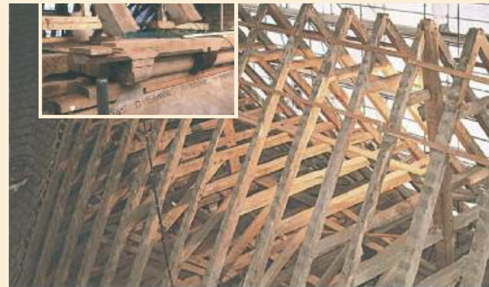
Dachstuhlrestaurierung im Kloster Marienmünster.
