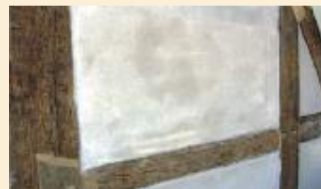
Zweilagiger Kalkputz als Außenputz, Oberfläche abgerieben, mit umlaufendem Kellenschnitt.
