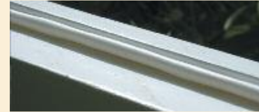
Zusätzliche Siliconzugluftdichtung in den Blendrahmen eingefräst und eingezogen.
