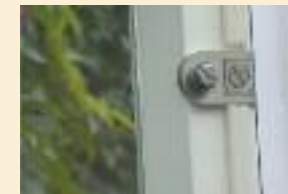
Ganzglasscheiben-Drehscharnier in Edelstahl gebürstet mit D-Profilabdichtung.
