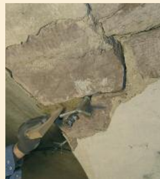
Verpressungs-Injektion von Gewölberissen:
