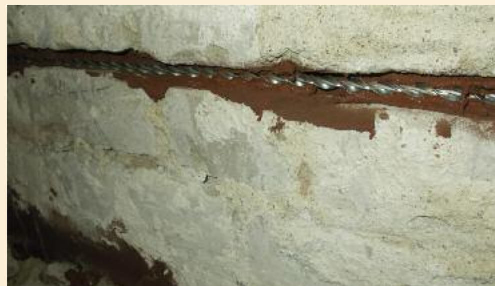
Horizontaler Spiralanke mit speziellem Ankermörtel im System.
