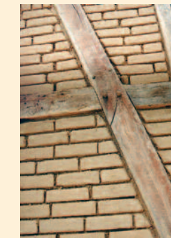
Fachwerksausfachung aus Leichtlehmstein, Rohdichte 1200 kg/m 3
