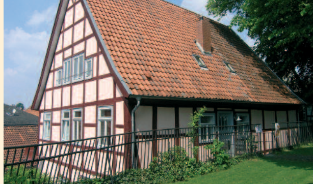
Altes Küsterhaus, Bad Salzflun Lehmausfachung mit einem Kalkputz
