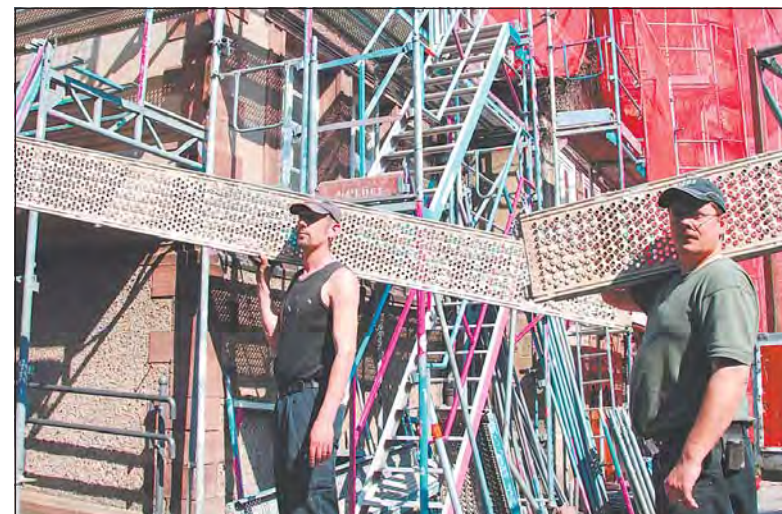
Jetzt wird in die Hände gespuckt: Michael Wojowski (links) und Markus Wobedo bauen hunderte Meter Gerüst am Amtsgericht Höxter auf.
