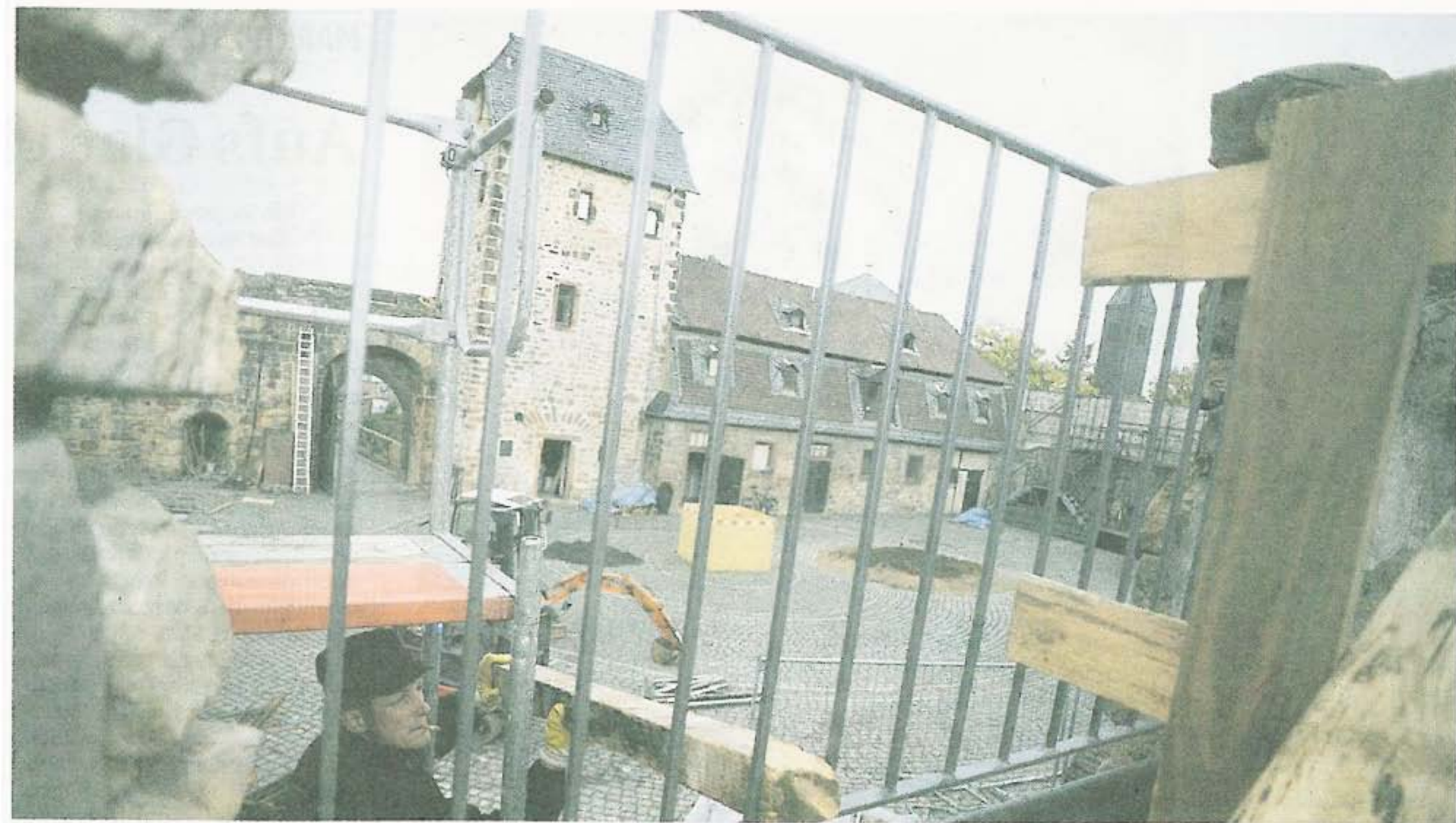
An der Wilbeler Burg wird gebaut.
