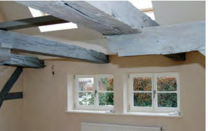
Dekorativ: Die alten Eichenbalken wirken wegen des hellgrauen Anstrichs nicht erdrückend und geben den Wohnungen das gewisse Etwas. Zusätzliche Oberlichter sorgen für genügend Helligkeit.
