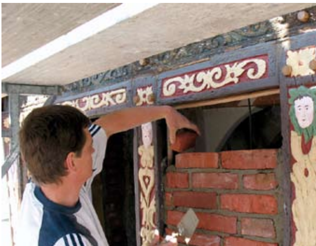
Ausmauerung von farbigem Fachwerk an einem Torhausgiebel aus dem Jahr 1593 in Lemgo
